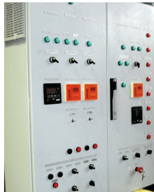
Шкаф управления к вакуум-фильтру ДОО-100/ Control cabinet for DOO-100
